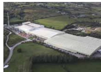
Planta de Derrylin, Irlanda del Norte
