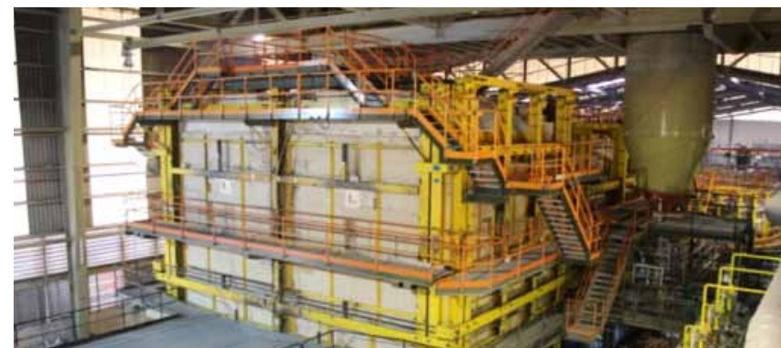
Nuevo horno instalado en Crisnova Vidrio.
