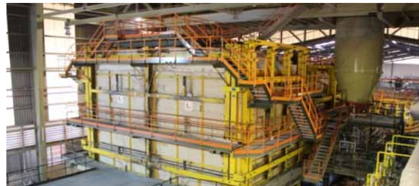
Nuevo horno instalado en Crisnova Vidrio.
